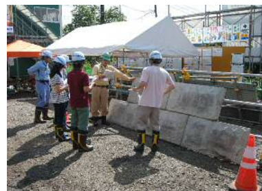
体験「社宅裏沢砂防堰堤工事」
