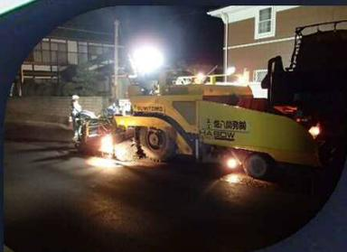
切削機（マシンコントロール）にて施工
