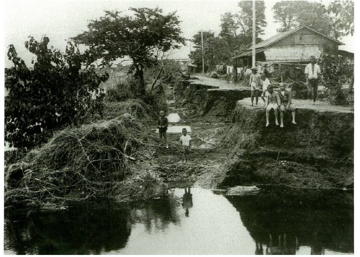
下都賀郡生井村下生井(現:小山市)の被害状況
