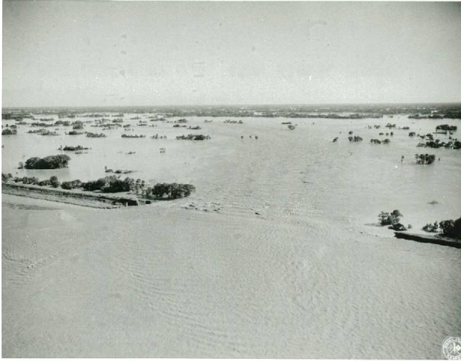
北埼玉郡東村(現:加須市)決壊状況
