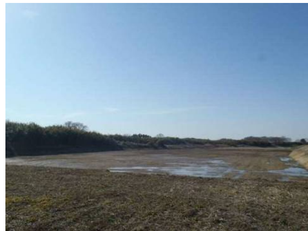
写真④：完了後(下流から上流を望む)
