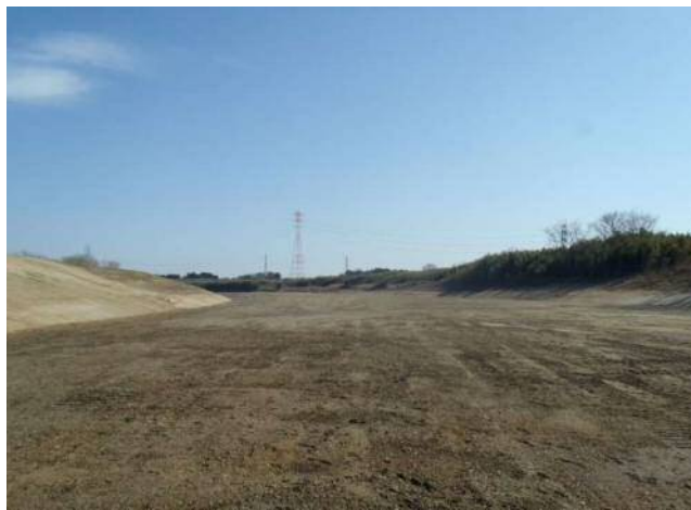
写真②：完了後(上流から下流を望む)
