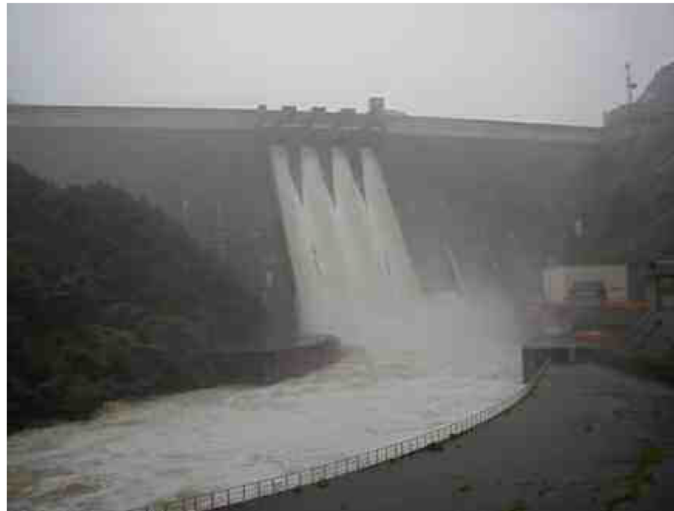
計画規模を超える洪水時のダムからの放流状況
