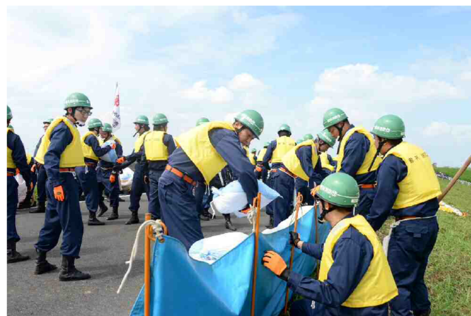
改良積土のう工法
