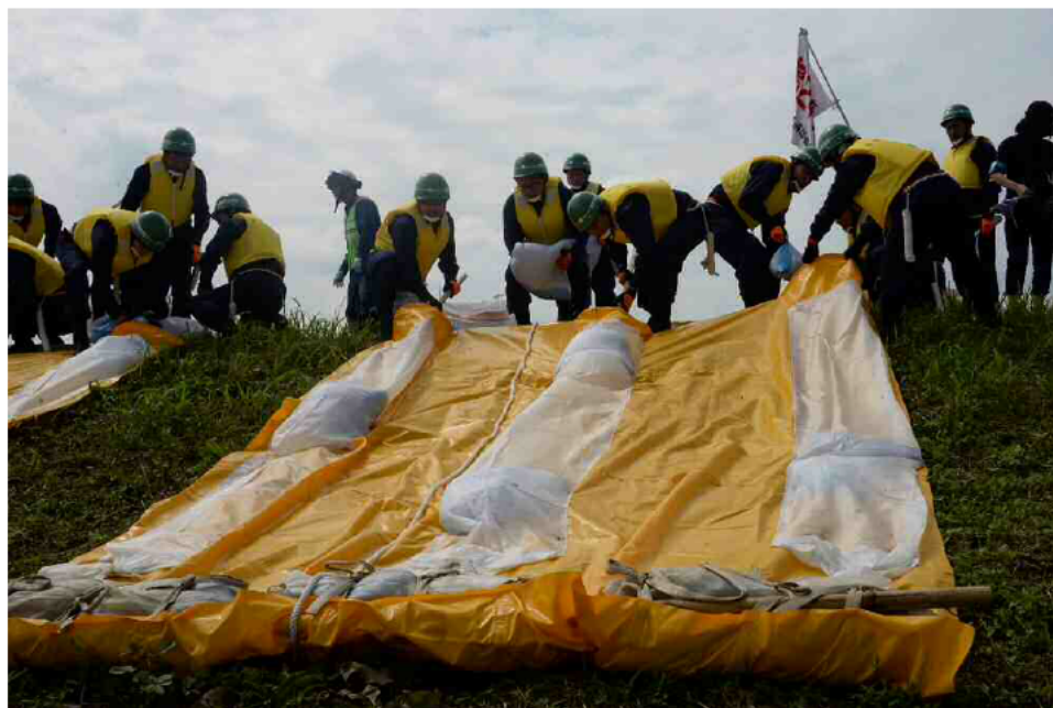
水防マット工法
