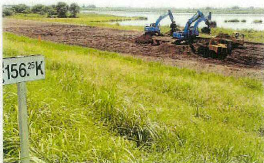
●堤防下での造成工事が進む利根大堰上流左岸の千代田町域の河岸部
