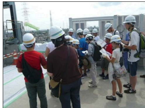
三郷中央インターチェンジ工事現場の説明
