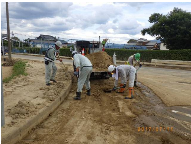
土砂堆積量が多い場所は、人力で清掃を実施
