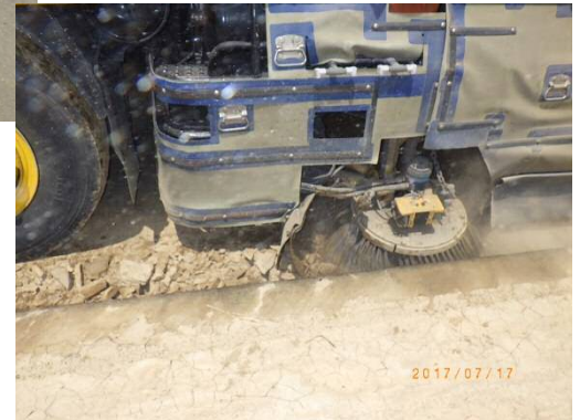
土砂の掃き込み状況
