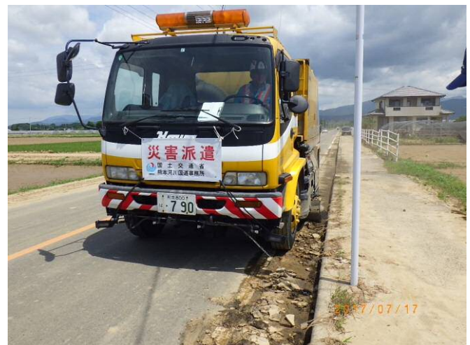
路面清掃車による土砂除去状況
