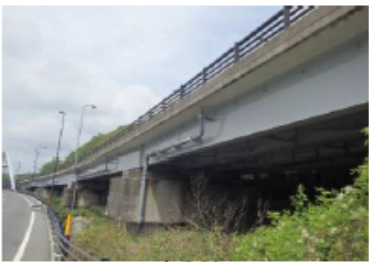
写真-4 阿蘇口大橋 (国道57号)
