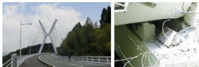
写真-2 支承部の損傷に伴う桁端部の浮き上がり (県道熊本高森線・桑鶴大橋)
