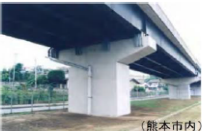
写真-3 国道3号 跨線部
