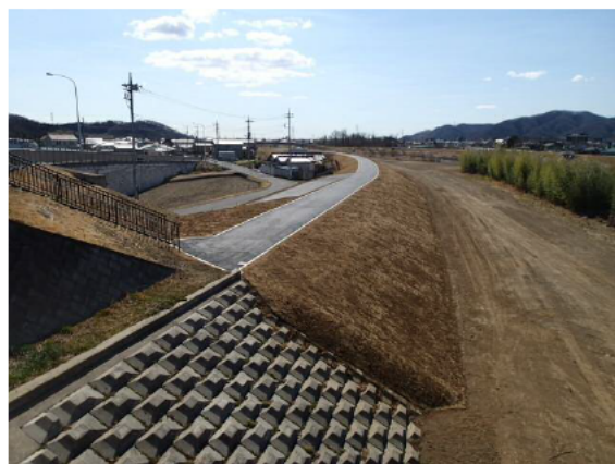
両国橋左岸下流付近の堤防法面完成風景
