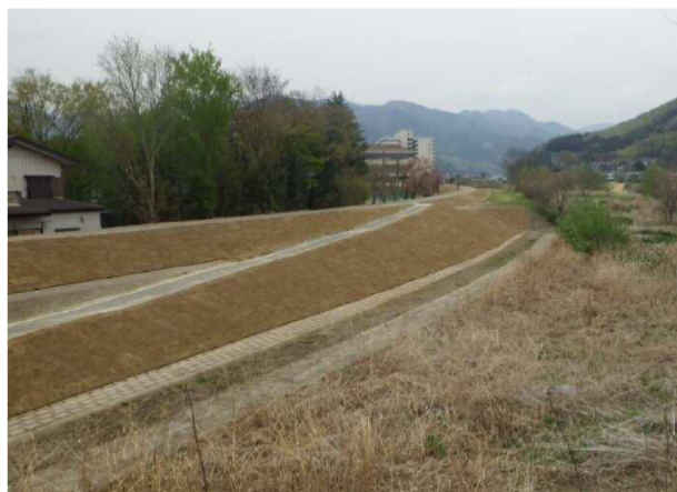
桐生川右岸 広見橋から上流の完成状況(平成 29 年 4 月現在)
