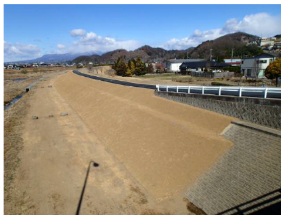
上濁沼橋左岸上流付近の堤防法面完成風景
