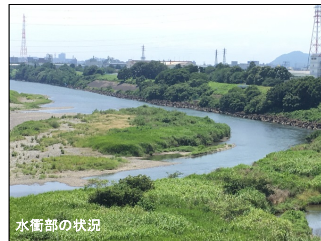
高さが不足している堤防
