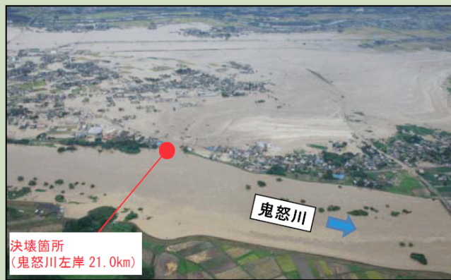
▲鬼怒川、平成27年9月関東・東北豪雨の堤防の決壊状況
