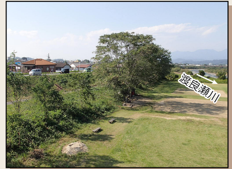
▲断面不足の堤防（桐生市相生町）
