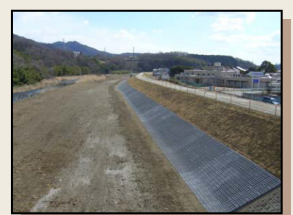
▲法面補修完成
