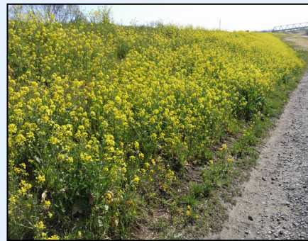
▲堤防の維持管理が必要な事例 (カラシナ繁茂による堤防の弱体化)
