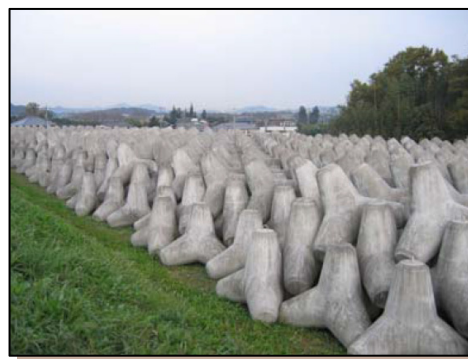
▲奥戸河川防災ステーションの備蓄資材
