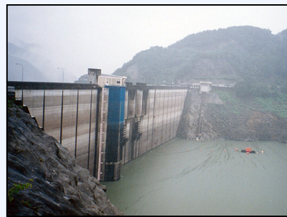
▲平成8年渇水における草木ダムの状況
