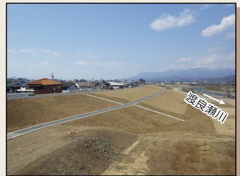
▲整備後の堤防（桐生市相生町）
