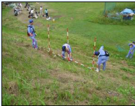
▲堤防の点検状況
