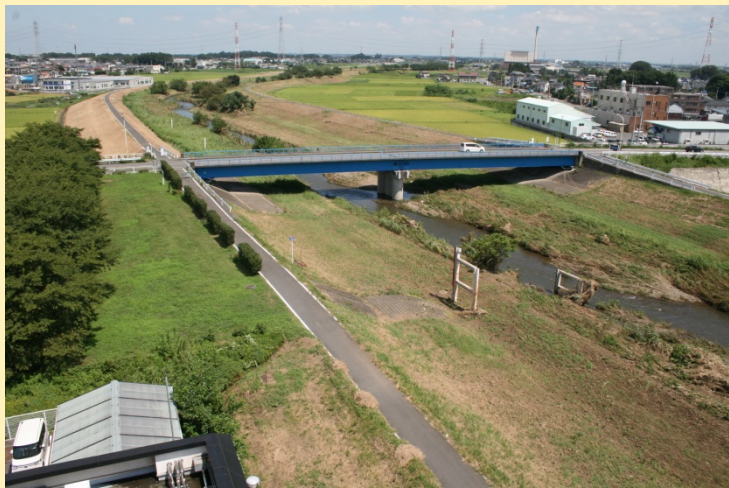
小畔川の堤防（川越市）
