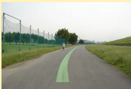
緊急用河川敷道路
