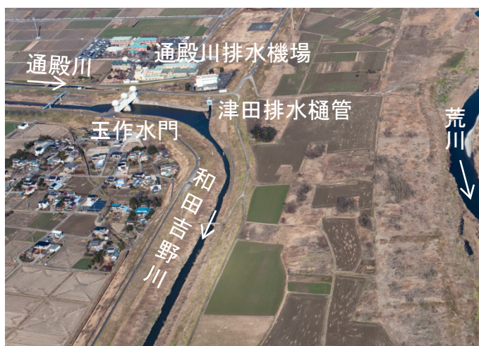
通殿川排水機場 空撮
