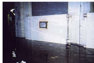
入口の水門使用状況 （平成11年8月洪水）
