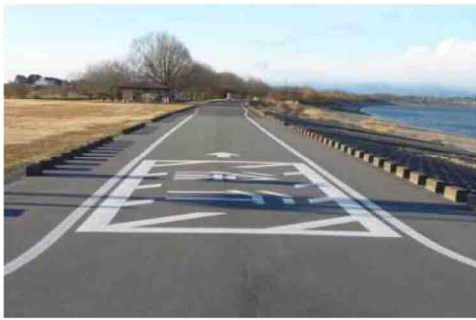
路面標示「徐行」、路側帯の拡幅
