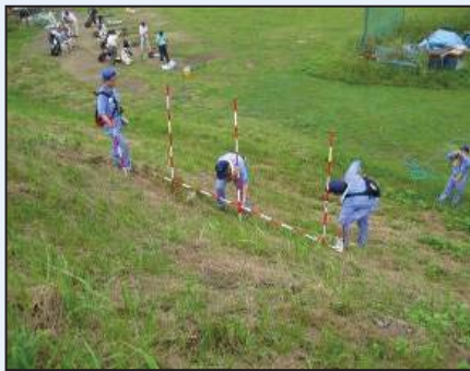
▲堤防の点検状況
