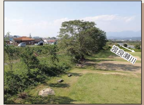
▲断面不足の堤防（桐生市相生町）
