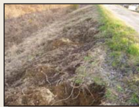
▲イノシシによる法面損傷状況
