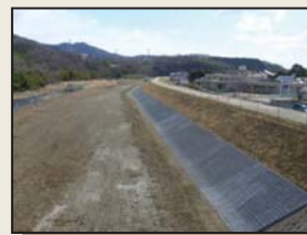
▲法面補修完成
