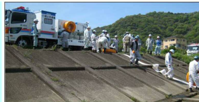
排水ポンプ車の設置・排水訓練の様子
