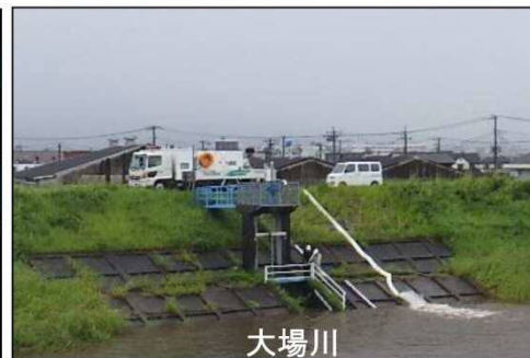
三島市御園地区での排水作業 ～建設業者による対応～
