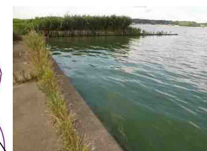
7/11 左岸24.75k付近(レベル2)
