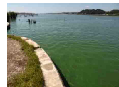
7/15 左岸27.0k付近(レベル2)
