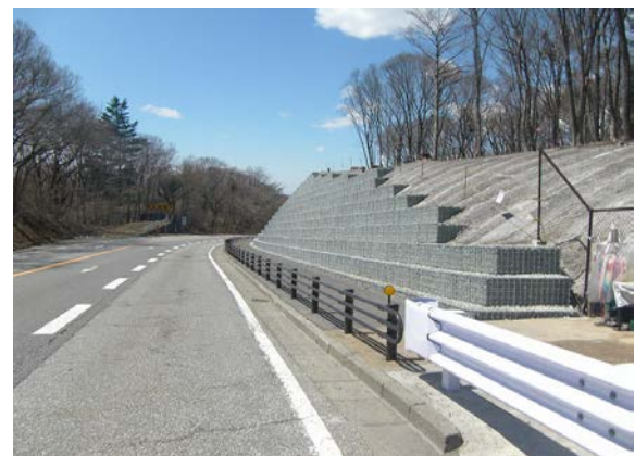
歩道設置完成
