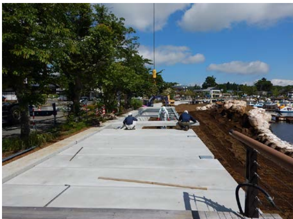
自転車歩行者道本体工施工状況
