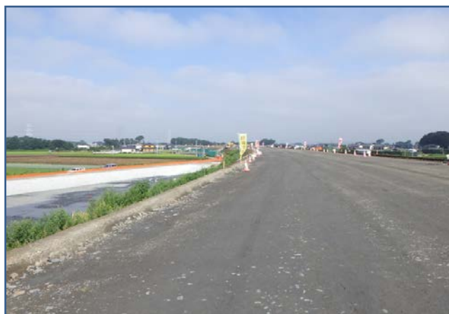
完成(路体盛土)
