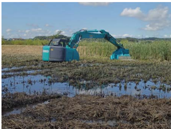
湛水箇所の除草状況
