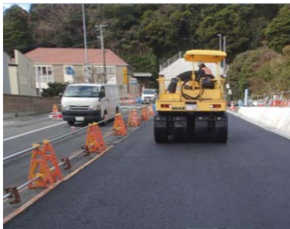
車道舗装締固め状況
