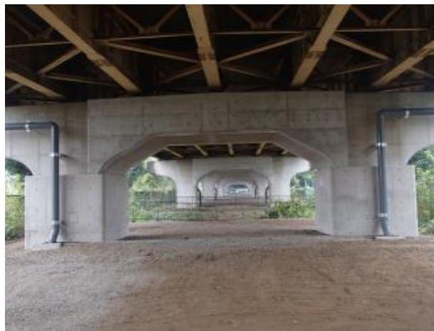
国道16号 中里跨道橋 完成
