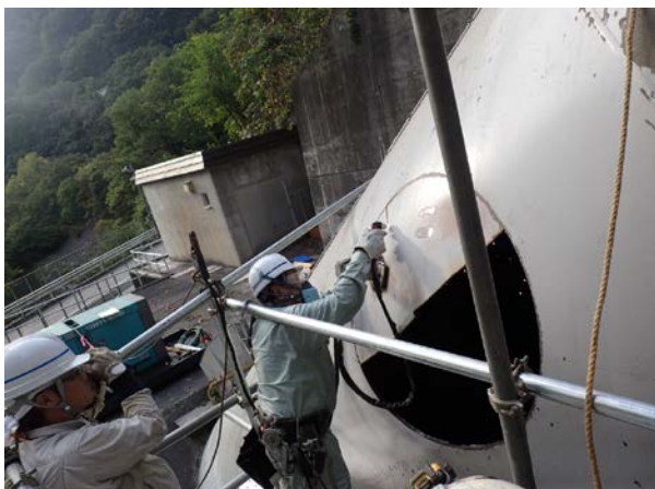
既設管分岐部穴開け施工状況
