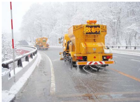
融雪剤散布施工状況
