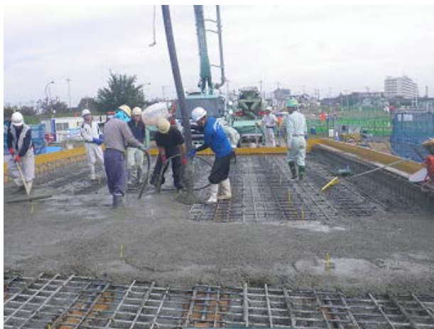
床版コンクリート施工状況(渡河橋)
