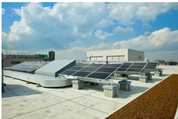
太陽光発電パネル設置状況
