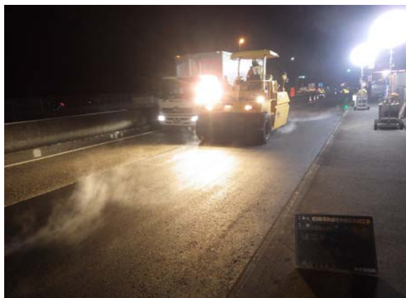
橋面部舗設施工状況
