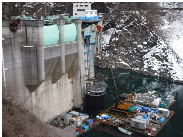
取水設備施工状況
