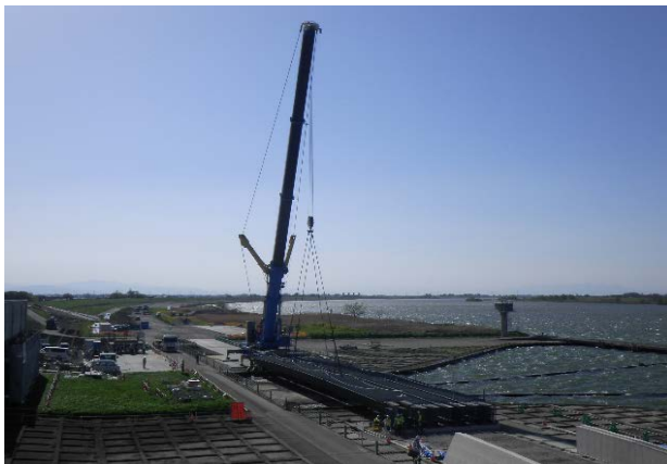
仮設橋架設施工状況
