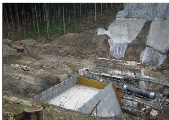
砂防堰堤施工状況(左岸法面对策及び掛樋)
