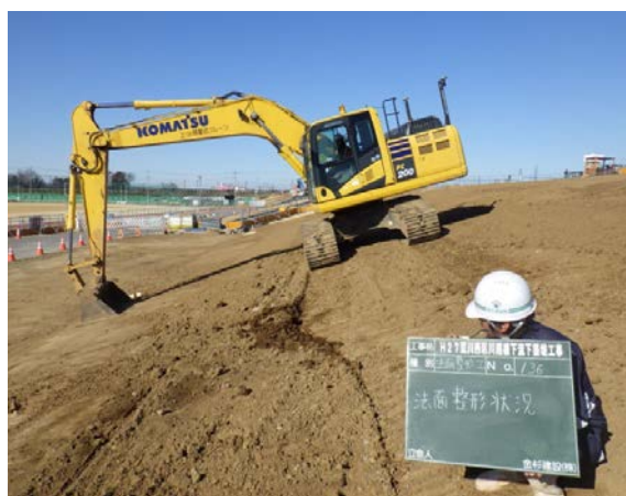
ICT建設機械による施工状況
