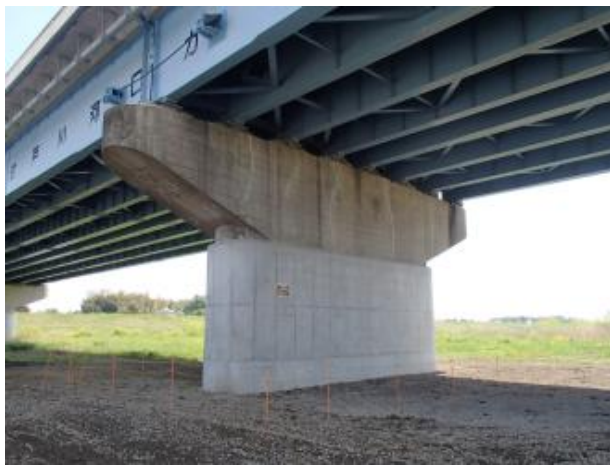
国道16号 金野井大橋P3橋脚 完成
