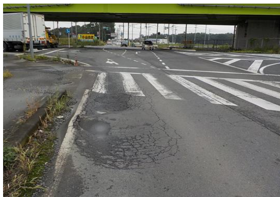
舗装工(既パッチング補修箇所)損傷状況
