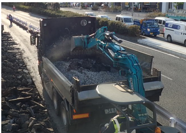
舗装版撤去の殻積み込み施工状況
