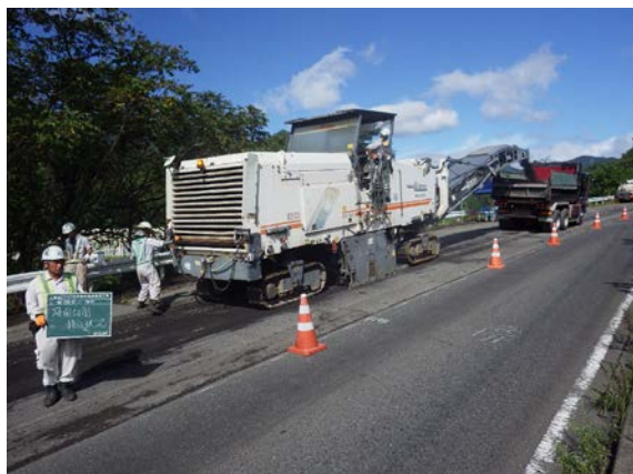
舗装切削施工状況
