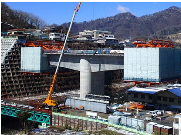
PC上部架設施工状況
