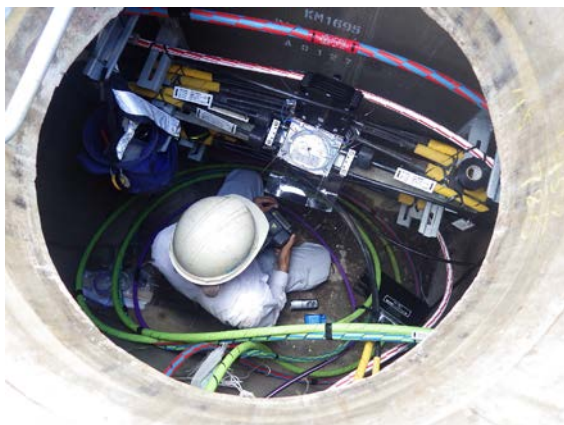
光ケーブル線接続状況
