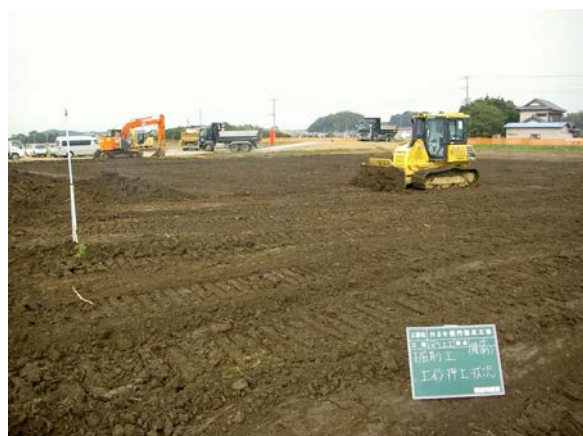
整正工施工状況
