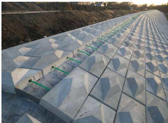
連節ブロック施工状況
