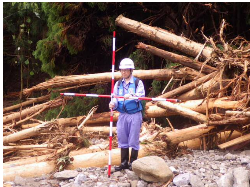
砂防班：宝珠山川にて被災状況調査
