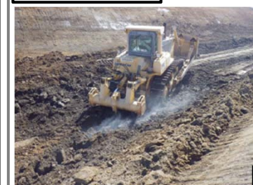
標準的工法 (リッパドーザ32t級)
