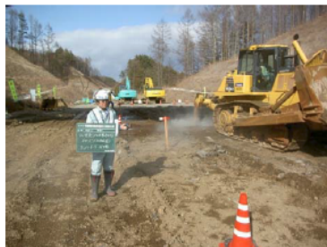
稼動20分: 表面部が破碎される
