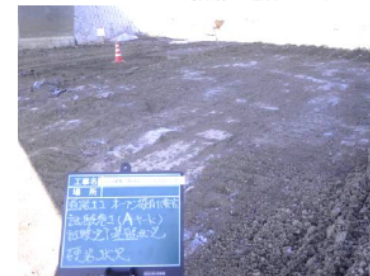
リッパドーザによる掘削の進行ほぼなし
