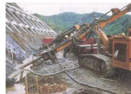
グラウンドアンカー工の施工例
