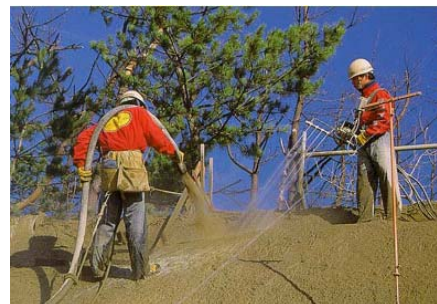
連続繊維補強土工の施工例
