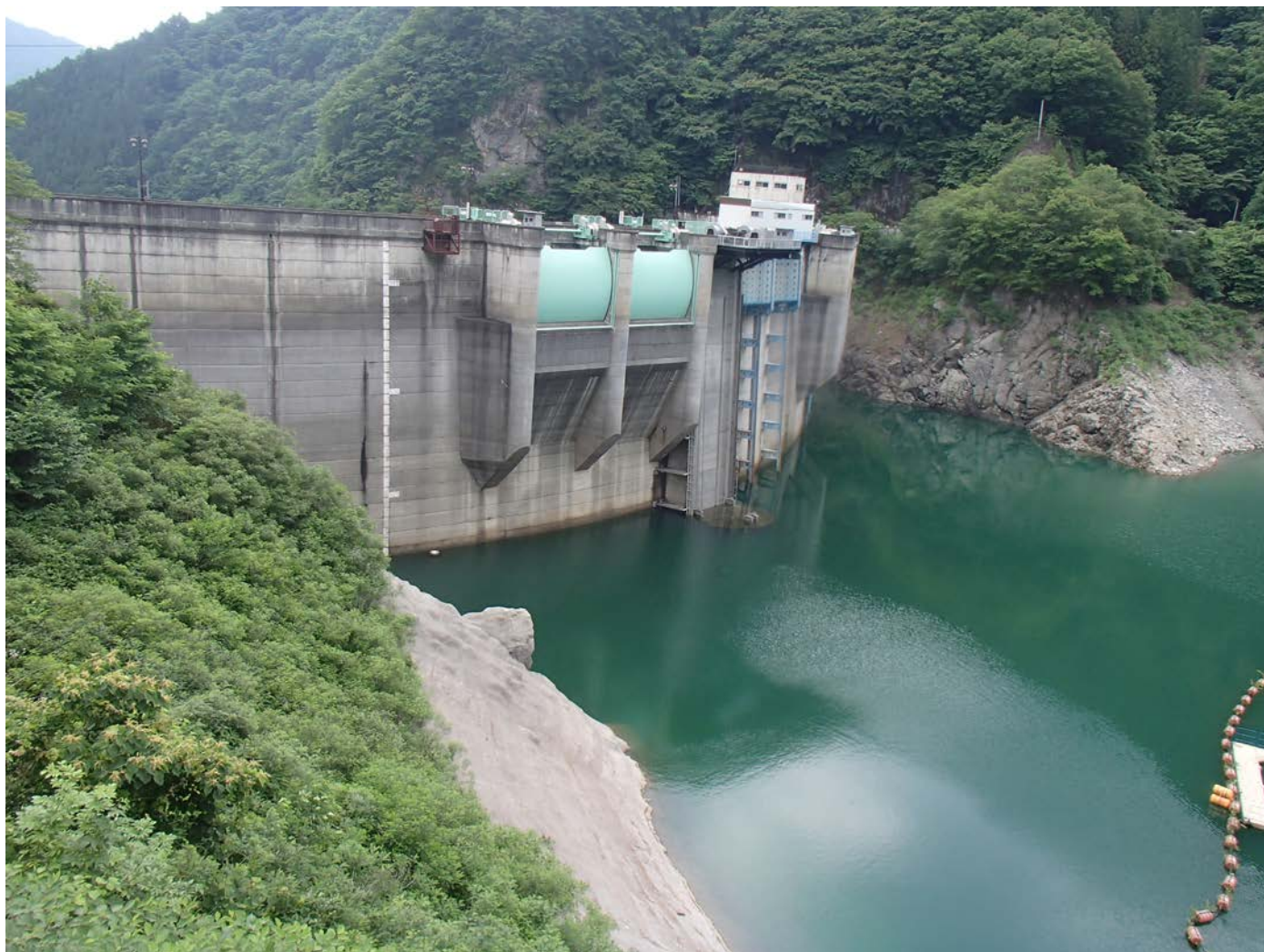
二瀬ダム上流部（平成29年7月3日撮影）
