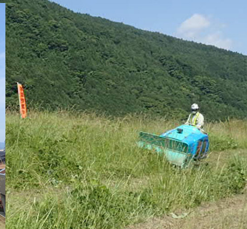
堤防の除草作業
