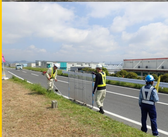
堤防の除草作業
