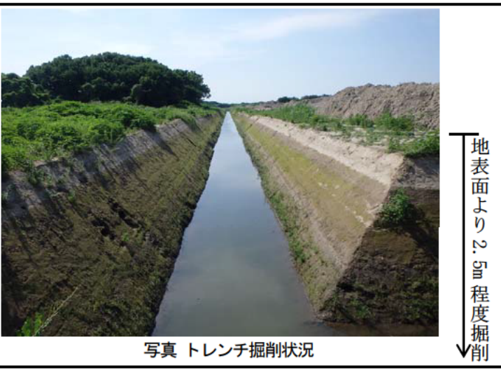
図7 トレンチ掘削の概念と実施状況
