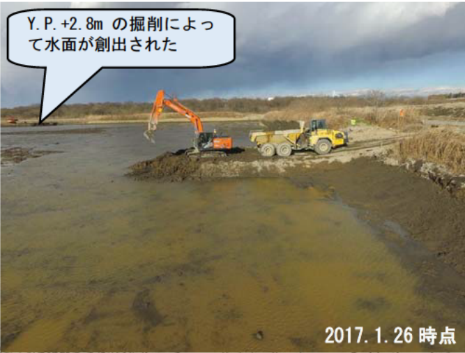
写真② 掘削ヤード①の水面創出状況
