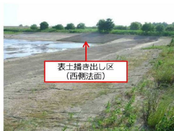
写真 1 施工後の掘削底面（Y.P.+2.8m）を囲む法面と表土播き出し区 （撮影：平成 22 年 5 月）
