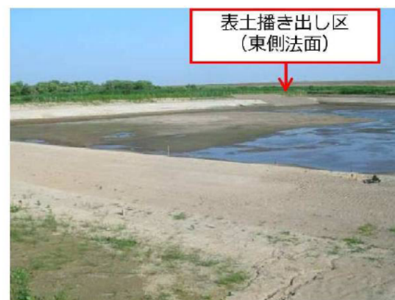
写真 1 施工後の掘削底面（Y.P.+2.8m）を囲む法面と表土播き出し区 （撮影：平成 22 年 5 月）
