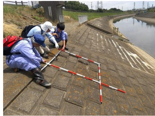
江戸川左岸33.2k付近、堤防に小規模な崩れ (要監視)
