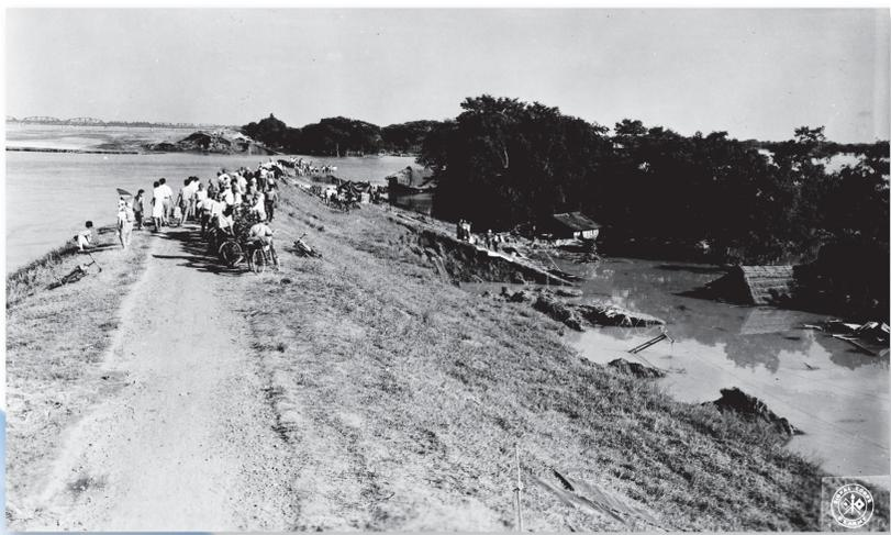
約400mに渡って崩れた破堤口付近に集まる人々。遠景に東武鉄道の利根川鉄橋が見え、川の上流から下流に向かって写している。画面左の利根川から破堤口へ向う流れはかつての利根川の本流だった。
