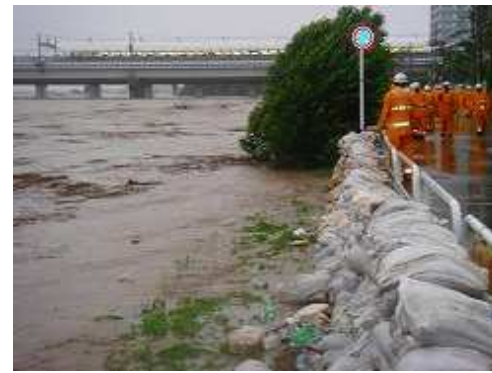
水防活動(土のう積み)
