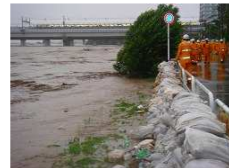
水防活動(土のう積み)
