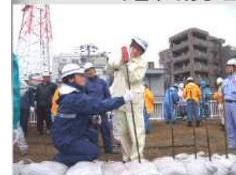
↑「積み土のう工」の習得
