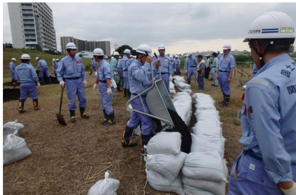
積み土のう工
