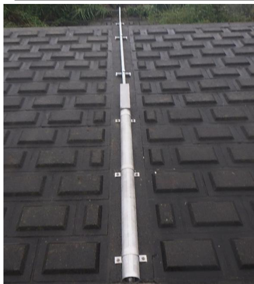
簡易水位計 設置状況
