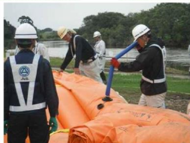
水注入の様子
