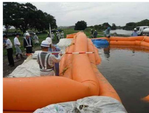
止水効果、設置高さ等の確認
