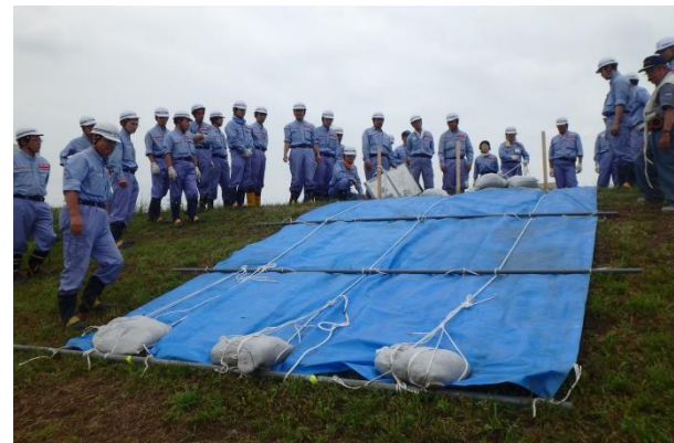
シート張り工
