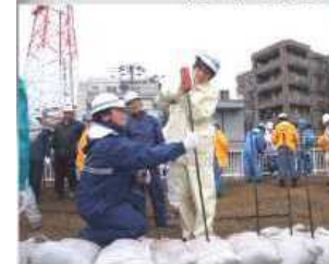
↑ 「積み土のう工」の習得
