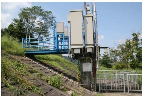
草花排水樋管
