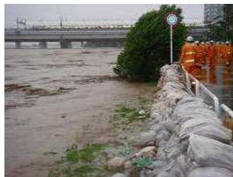
水防活動(土のう積み)
