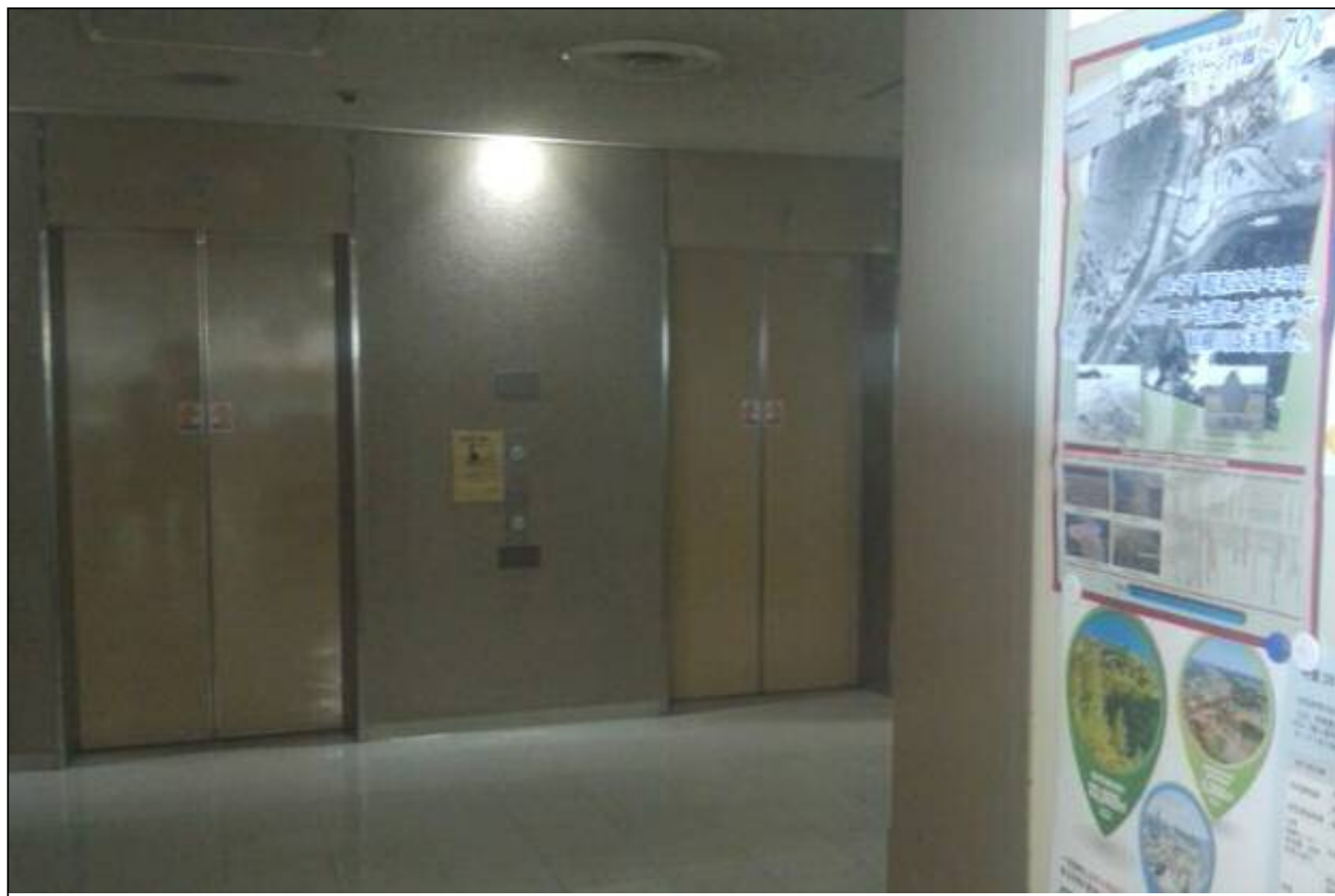
さいたま市役所11階エレベーターホール
