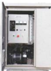
●自動起動発動発電機 停電時でも親局設備が使用できるように非常用電源設備を備えています。
