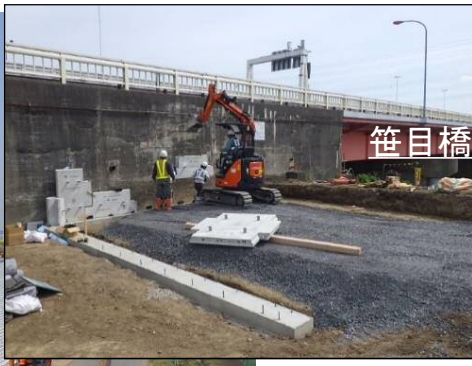
橋梁部周辺 (施工状況)
