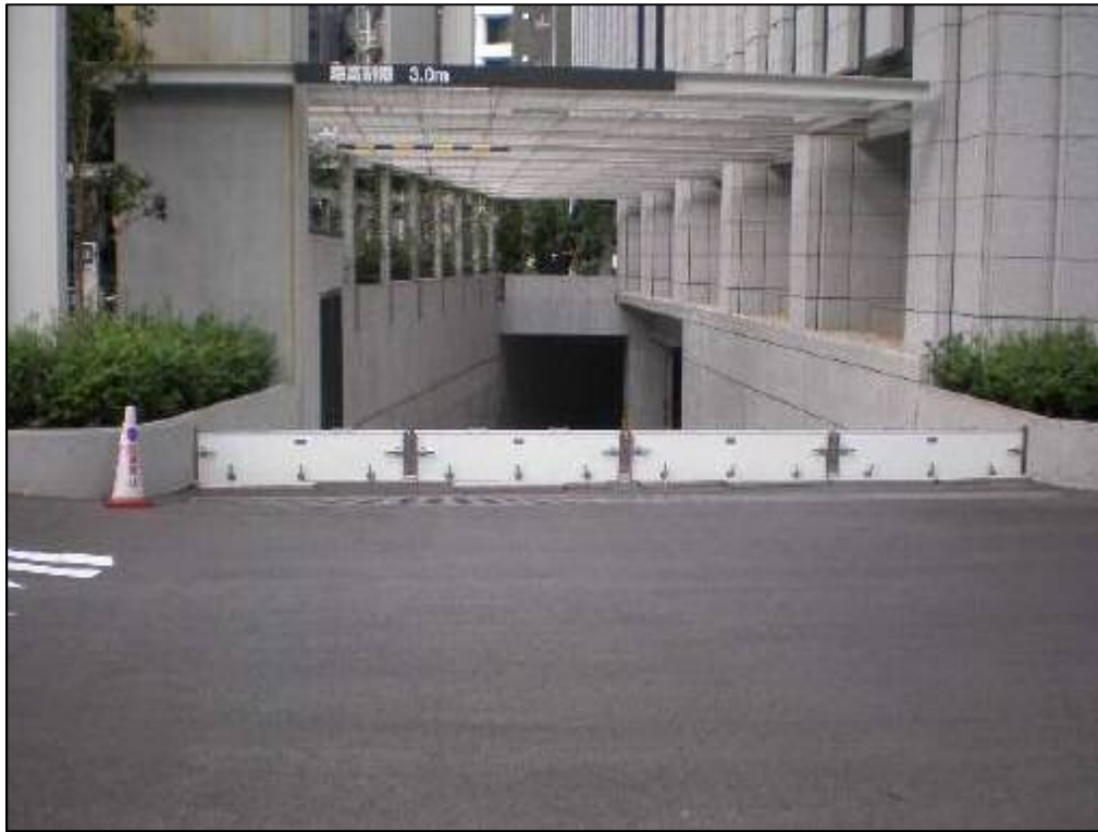
止水板の配備状況(千代田区)
