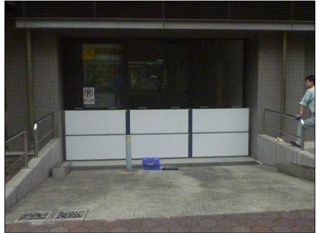
止水板の設置確認状況(江東区)
