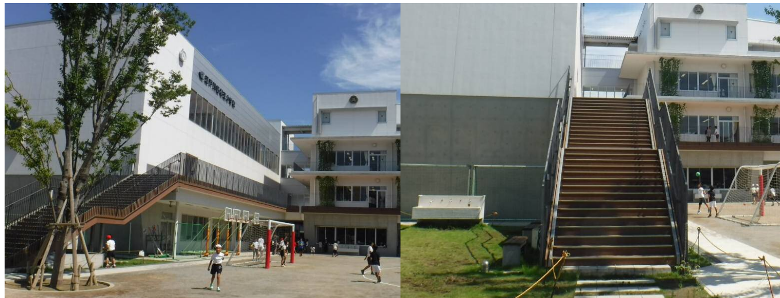
体育館及び防災倉庫を2階に設置(江戸川区)
