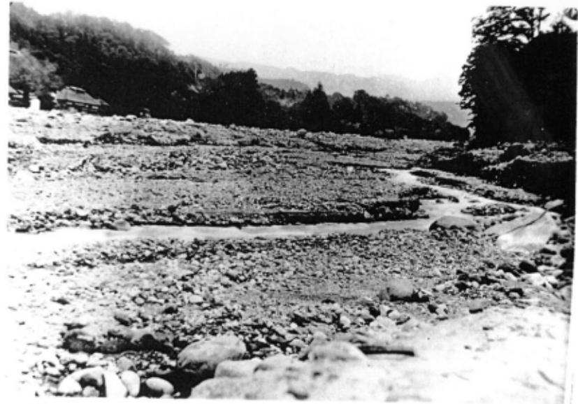
勢多郡赤城村長井小川田。沼尾川に架かる小川田橋流失他付近の堤防、道路、耕地は原形を残さず石礫累々とした賽の河原と化す。
