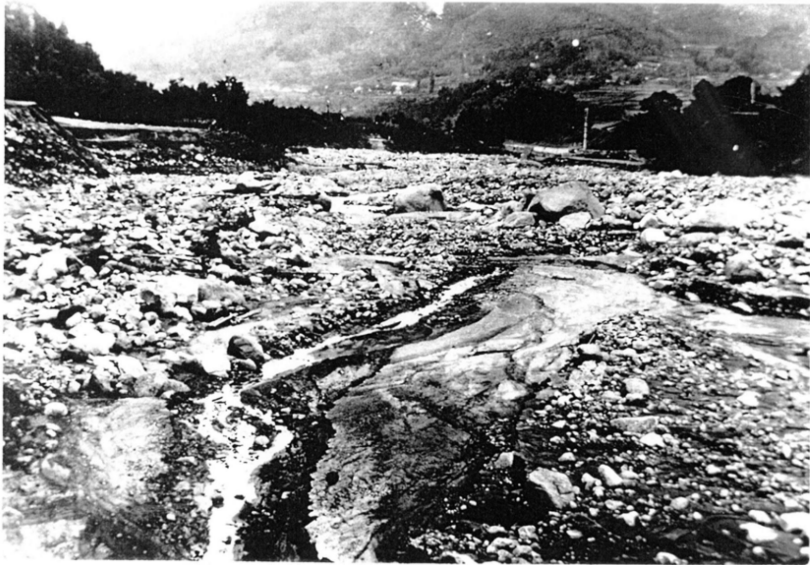
勢多郡赤城村津久田。上越線沼尾鉄橋の流失状況。
