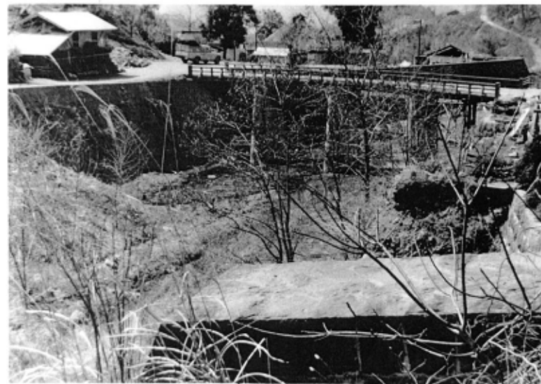
床園群が完成した前入沢筋のその後の状況
