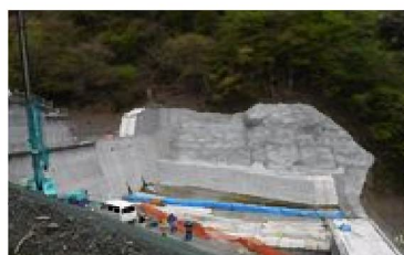
H27池の沢第二砂防えん堤工事
