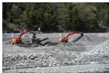
H28白河内工事用道路工事
