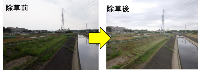
坂川左岸 流山市幸田付近
