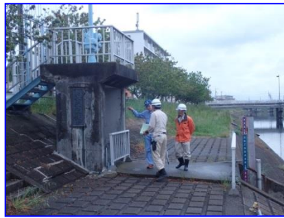
樋管の履行検査(坂川(放水路))
