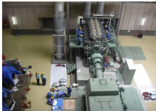
ポンプの部品をばらしているところ
