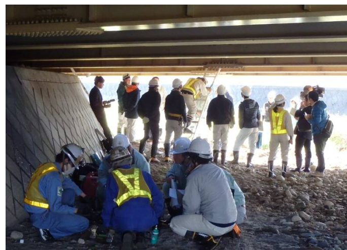
(現地点検の状況)
