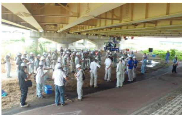
(現地点検の状況)
