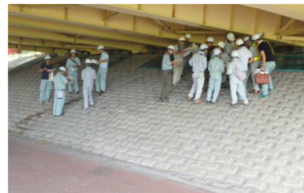
(現地点検の状況)
