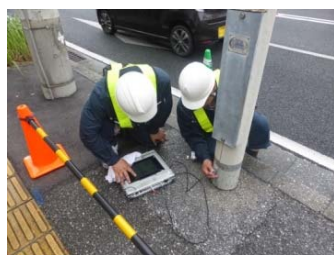
非破壊調査技術を用いた道路照明柱：路面境界部付近の損傷調査の状況
