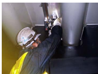
鋼床版疲労亀裂の超音波探傷法による自動探傷の状況
