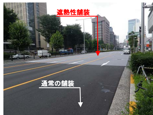
＜施工事例（遮熱性舗装）＞
