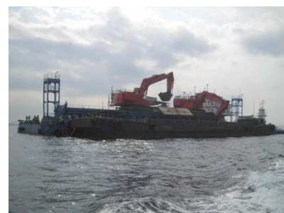
作業船による覆砂作業の実施風景
