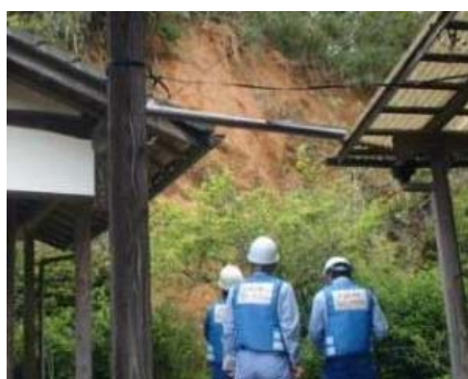
急傾斜地崩壊危険箇所の調査
