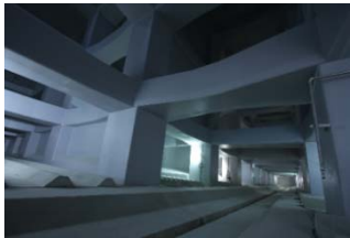
雨天時貯留池 (品川区)
