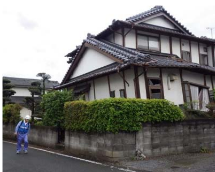
建物被害状況の調査
