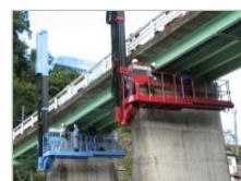
↑ 上部工の損傷状況調査
