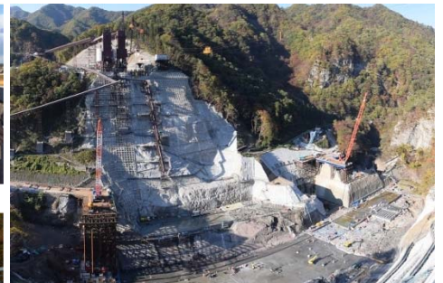
ハッ場ダム 展望台から見た工事現場
