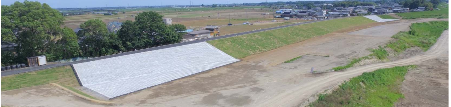
平成28年9月 堤防部分完成
