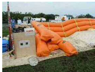
訓練後の状況 ※今回は2,3段の水注入
