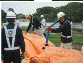
水注入の様子
