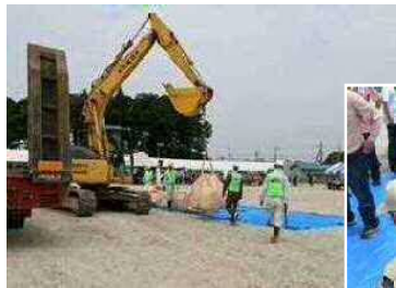
重機を用いた 大型土のう設置訓練
