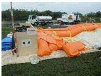
訓練前の状況 ※上流側は1段目のみ事前に水注入
