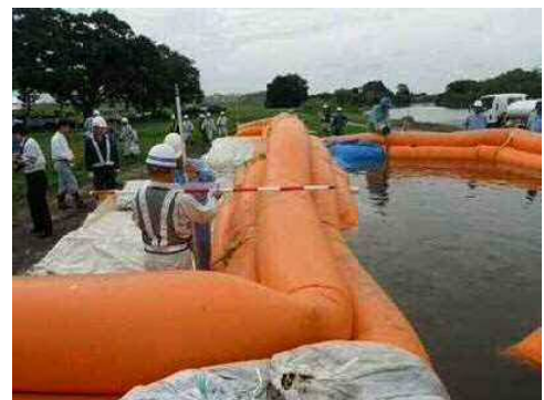
止水効果、設置高さ等の確認
