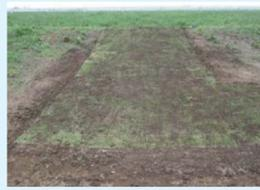
巣穴は部分的に掘り起こし、穴を完全に埋め戻すよう補修。
