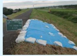
陥没箇所は、その影響範囲を考慮して掘削後、覆土して補修。
