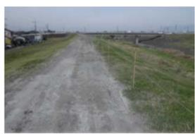
碎石による締固めにより不陸を解消
