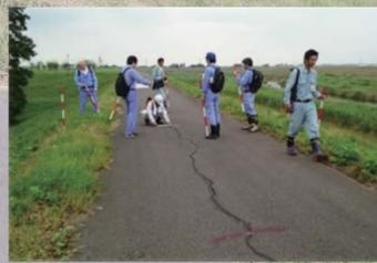
堤防点検による堤防天端の舗装クラックの状況把握
