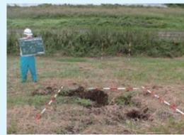
河川巡視で降雨後の堤防川側法面が陥没しているところを発見。
