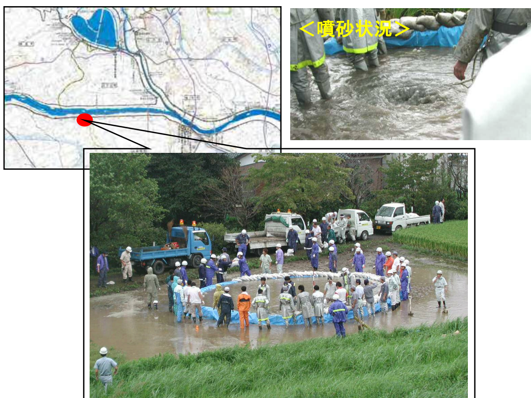
写真 3-5 水防活動（釜段工法）による漏水対応（加須市大越地先）
