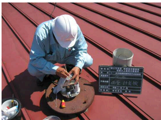
写真 5-5 雨量計点検状況
