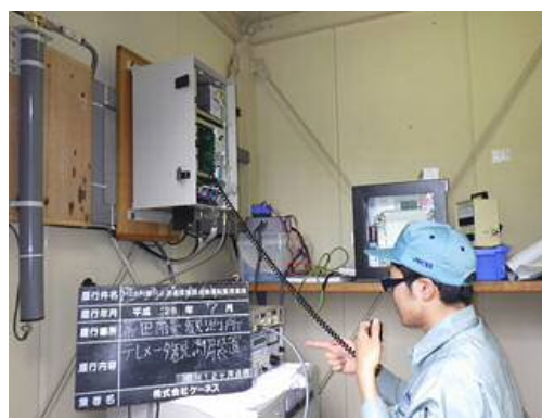
写真 5-7 テレメータ装置点検状況
