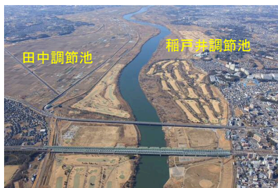
写真 1-6 田中・稲戸井調節池周辺（約 90km）
