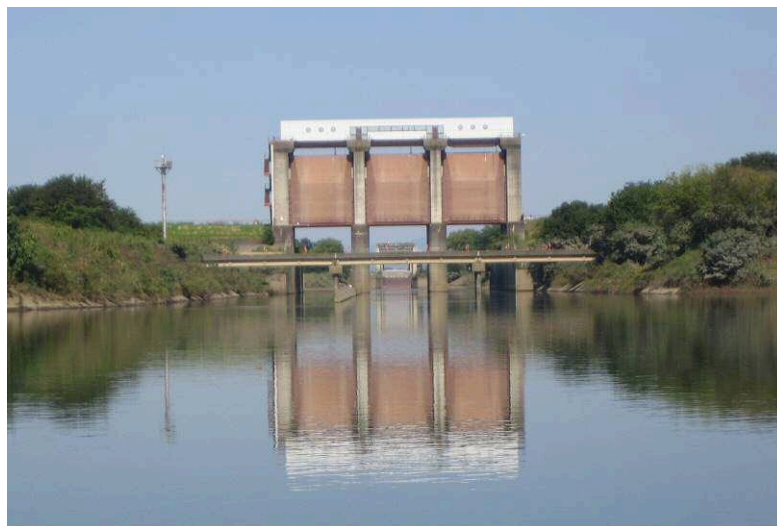
写真 3-4 渡良瀬調節池第 1 排水門（渡良瀬川右岸 4.5k） （昭和 45 年設置 47 年経過）
