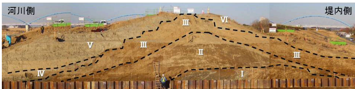
写真 6-3 堤防開削調査（平成 26 年度御所沼排水樋管改築）の例
