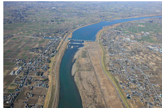
利根大堰下流
