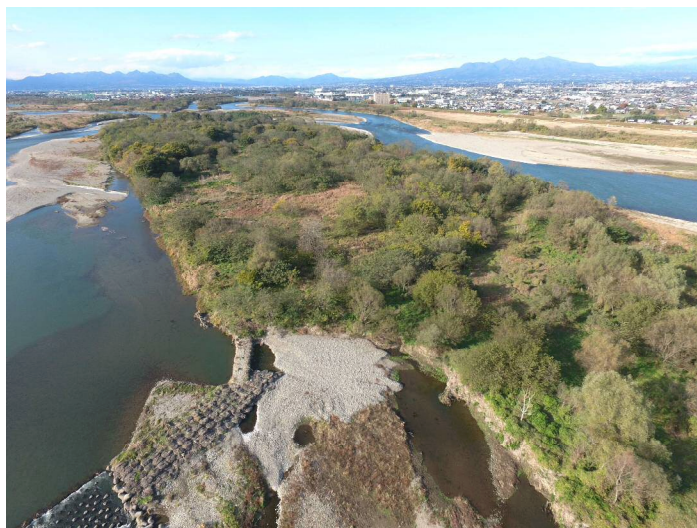
写真 6-2 河道内樹木の繁茂状況
