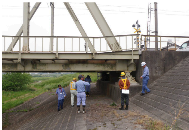
写真 3-9 橋梁の履行検査状況（損傷等がないか点検）
