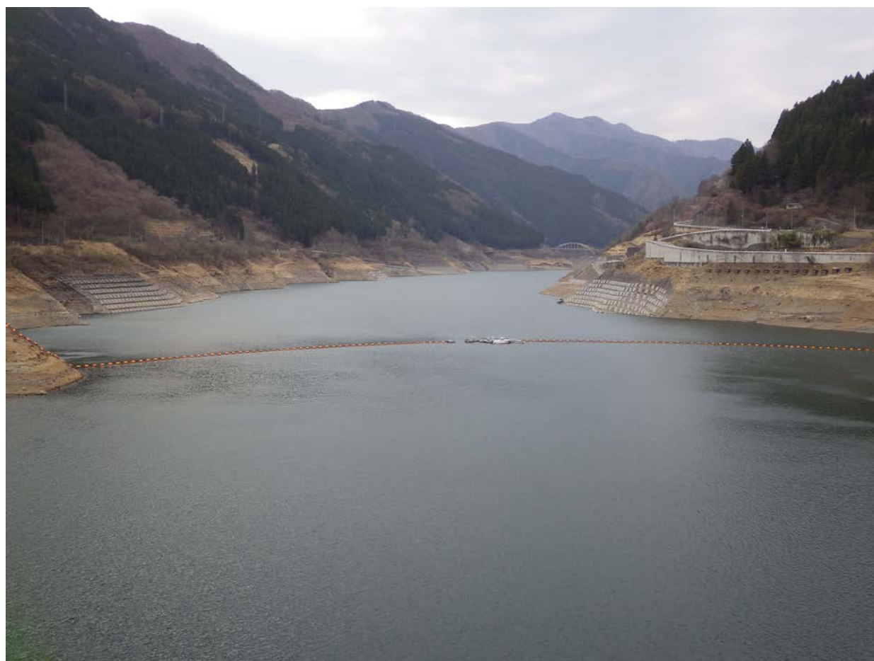
滝沢ダム(平成29年4月17日撮影)
