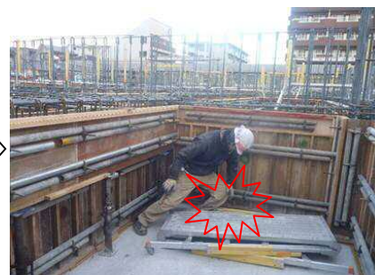
型枠上から落下し負傷
