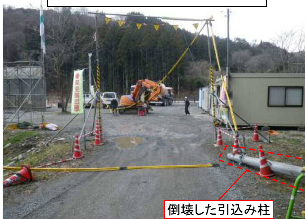
架空線・引込み柱 損傷状況
