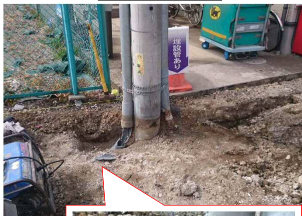
埋設管損傷状況
