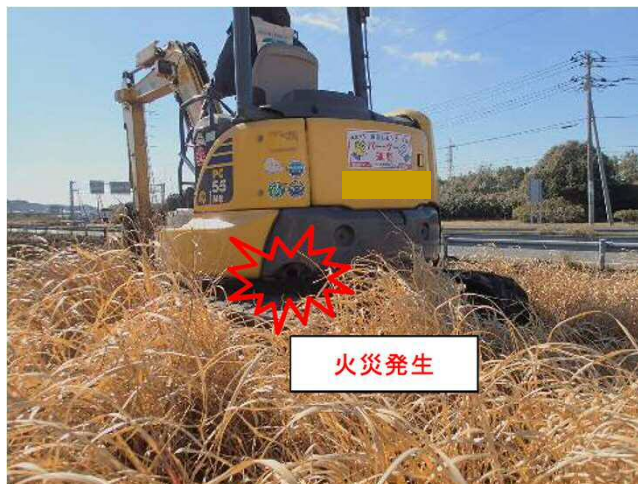
発生時の作業状況
