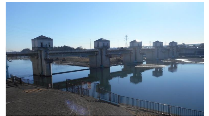
新六堰頭首工(平成15年3月完成)
