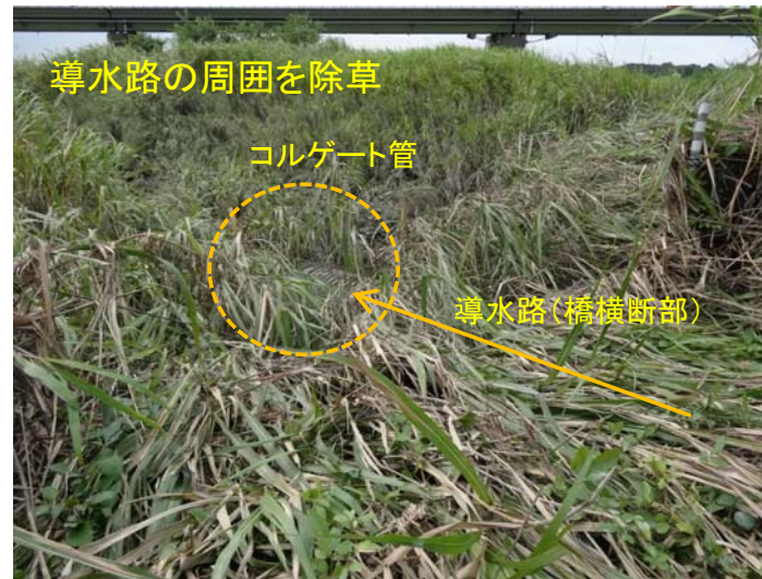
導水路の橋横断区間
