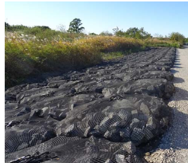
復旧状況（平成28年11月）
