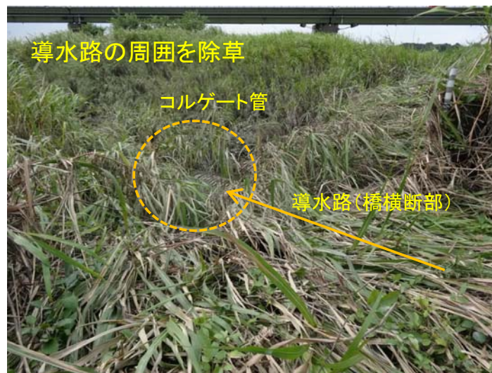
導水路の橋横断区間
