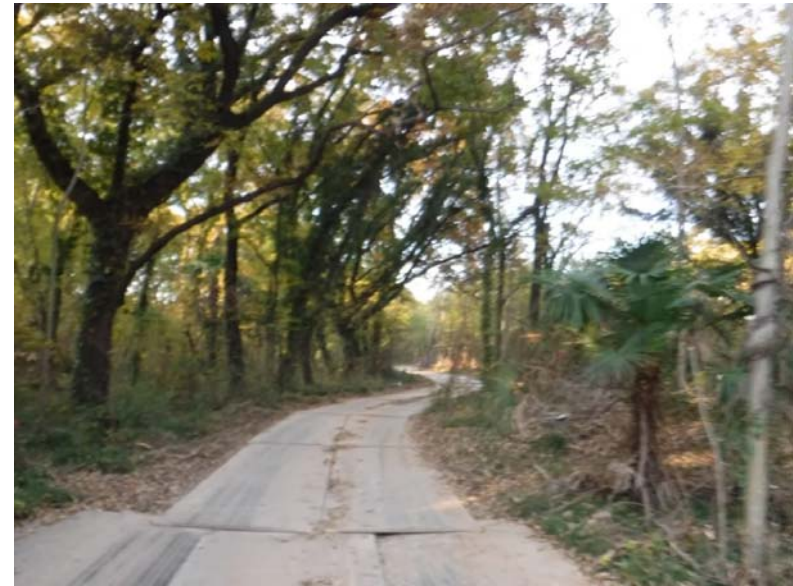
樹木を避けて設置した工事用道路
