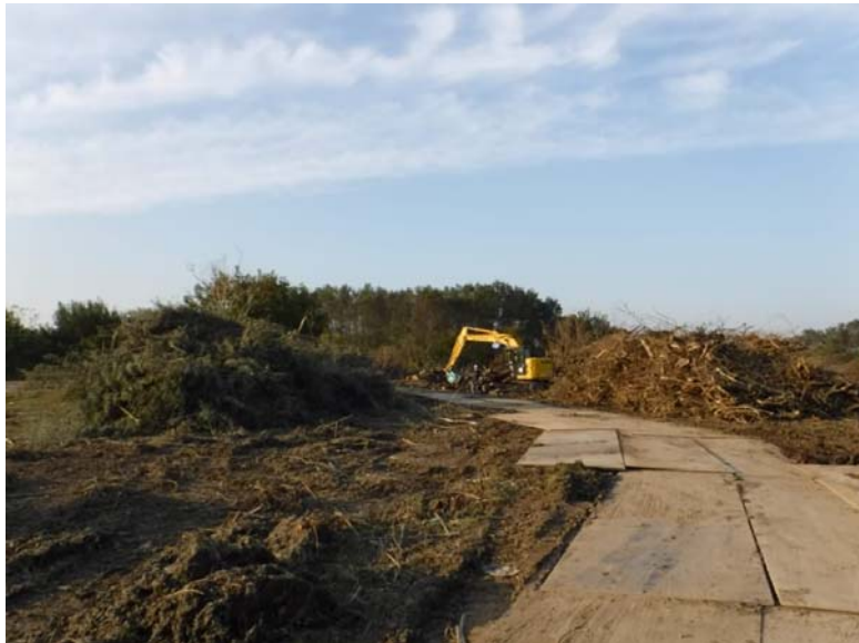
掘削予定地区間
