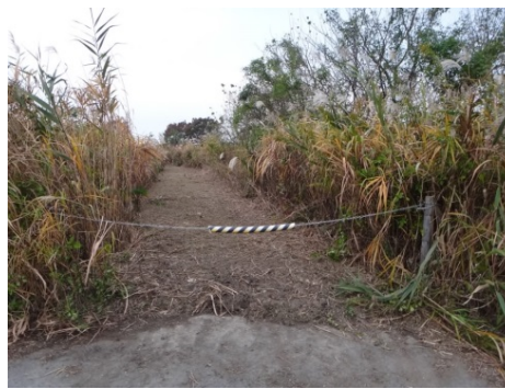
管理用通路の除草後の様子
