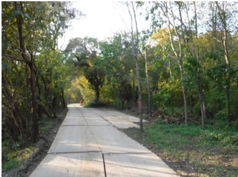
既設道路拡幅区間
