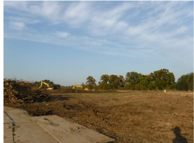
掘削予定地付近の様子
