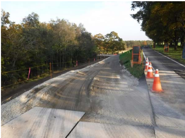
坂路の拡幅（堤外側）
