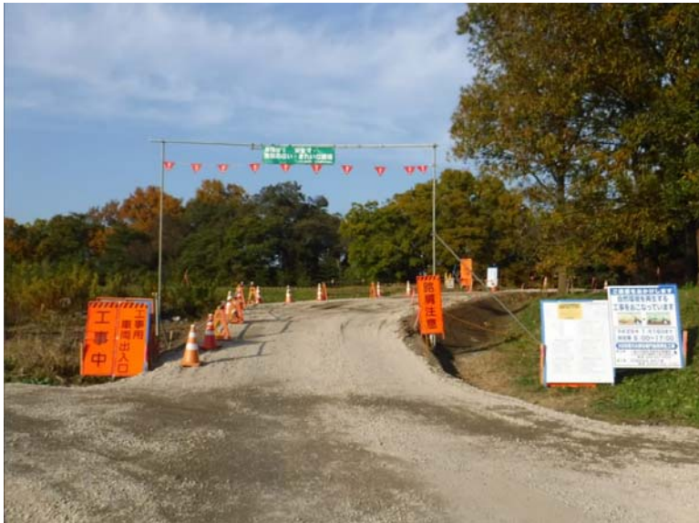
坂路の拡幅（堤内側）
