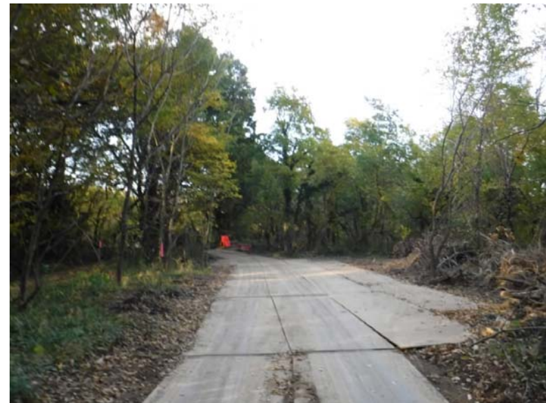
水路横断前の車両交換所
